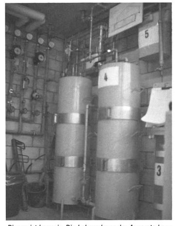
Biogas ist korrosiv. Die Lebensdauer der Apparate kann durch die Einschaltung einer Entschwefelungsanlage entscheidend verlängert werden.
