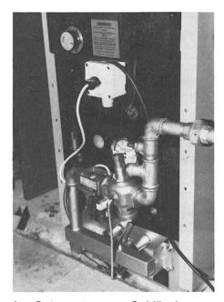
Im Gegensatz zum Gebläsebrenner wird beim «atmosphärischen» Brenner die Verbrennungsluft vom ausströmenden Gas passiv mitgerissen. Die Gasdüsen befinden sich hinter der Gaszuleitung mit dem rechteckigen Profil.
