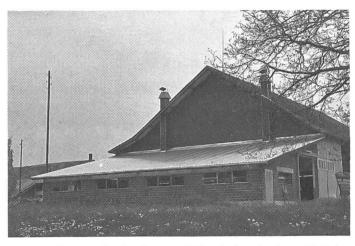
Abb. 1: Dieser Stallanbau enthält als Dach einen Kollektor von 190 m² mit durchsichtiger Polyesterabdeckung. Die Luft tritt bei der Traufe in den Kollektor ein, fliesst nach oben und wird vom Heulüfter von beiden Seiten zur Mitte gesaugt.
