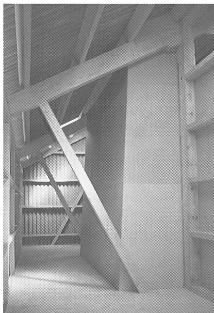
Abb. 13: Der Luftkanal verbindet den Sammelkanal mit dem Lüfter und sollte wenn möglich grosszügig bemessen werden.
