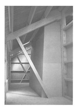
Abb. 13: Der Luftkanal verbindet den Sammelkanal mit dem Lüfter und sollte wenn möglich grosszügig bemessen werden.
