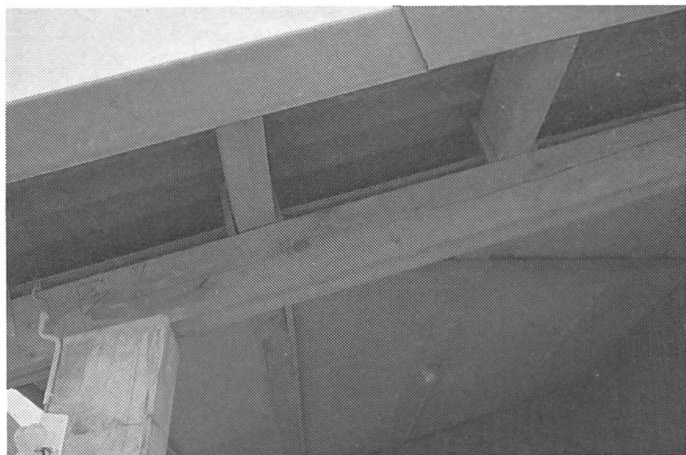
Abb. 5: Der Luftansaug erfolgt unter dem Vordach. Die Eintrittsöffnung in den Kollektor ist mit einem Netz versehen, damit die Vögel und der Treibschnee nicht eindringen können. Deutlich sind die zwischen die Pfetten verlegten Spanplatten zu erkennen.
