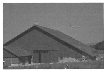
Abb. 2: Diese Siedlung verfügt über einen Eternit-Kollektor von gut 260 m2. Die Luft wird von einer Stirnseite her angesaugt, nach zirka 20 m gesammelt und über einen Kanal zum Lüfter auf der Nordseite geführt.
