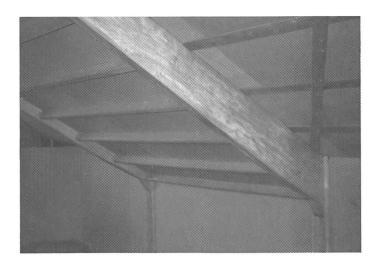
Abb. 11: Am Binder angeschlagene Balkenschuhe tragen die Balken des Sammelkanals.
