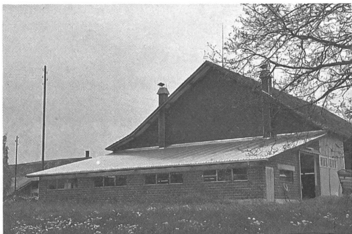
Abb. 1: Dieser Stallanbau enthält als Dach einen Kollektor von 190 m 2 mit durchsichtiger Polyesterabdeckung. Die Luft tritt bei der Traufe in den Kollektor ein, fliesst nach oben und wird vom Heulüfter von beiden Seiten zur Mitte gesaugt.
