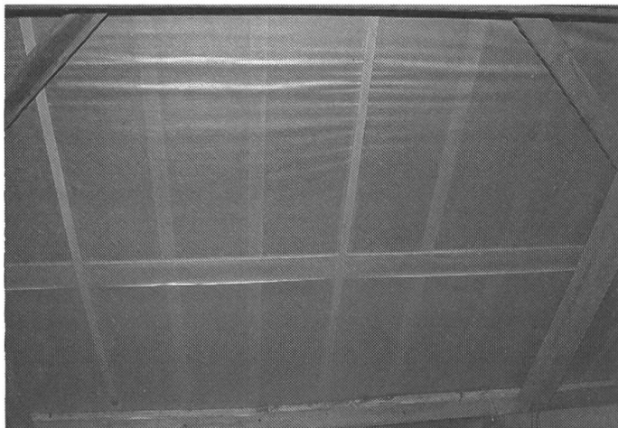
Abb. 9: Vor allem in Altbauten bietet sich mit dem Blachenunterzug eine günstige Alternative zum Spanplattenunterzug an, sofern nicht Verletzungsgefahr zum Beispiel durch einen Drehkran besteht.
