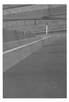
Abb. 12: Die Balken, welche die Spanplatten des Sammelkanals tragen, laufen in der Strömungsrichtung und sind mit Metallbändern an den Pfetten aufgehängt.
