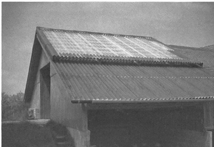
Abb. 8: Kollektoren beider Bauarten lassen sich auch nachträglich auf ein Dach aufbauen. Der Materialaufwand fällt jedoch höher aus als bei ins Dach eingebauten Kollektoren.
