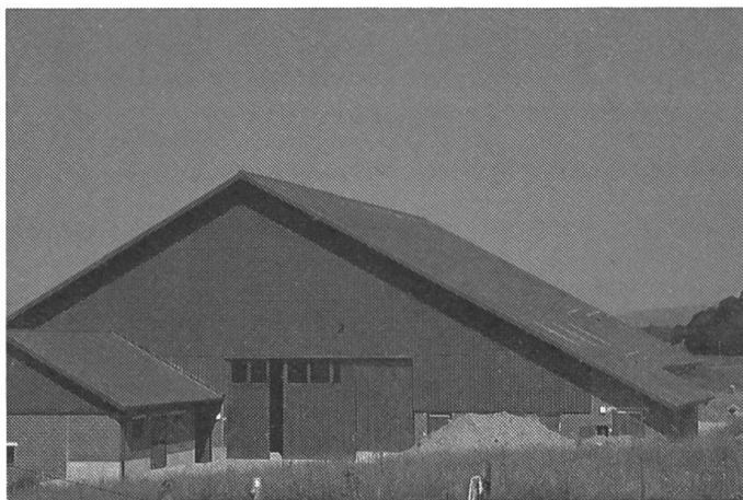
Abb. 2: Diese Siedlung verfügt über einen Eternit-Kollektor von gut 260 m 2 . Die Luft wird von einer Stirnseite her angesaugt, nach zirka 20 m gesammelt und über einen Kanal zum Lüfter auf der Nordseite geführt.
