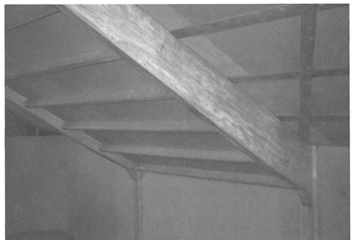
Abb. 11: Am Binder angeschlagene Balkenschuhe tragen die Balken des Sammelkanals.
