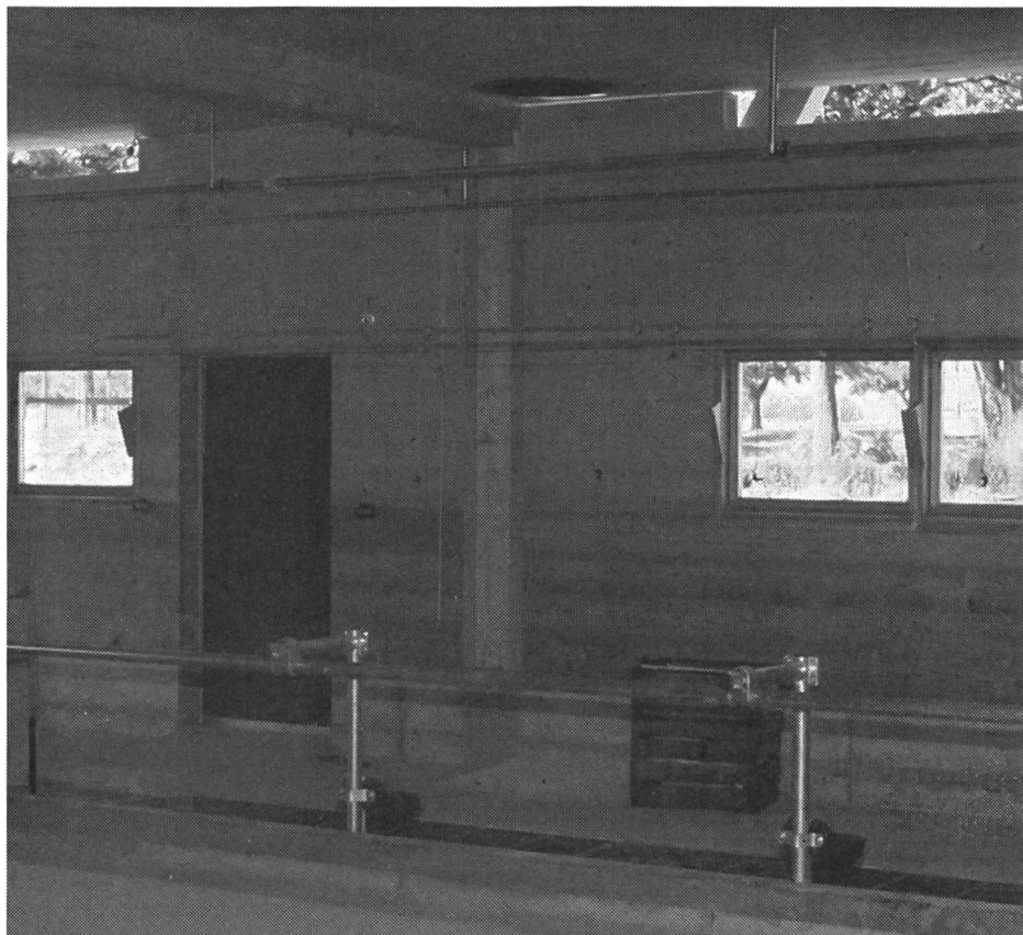
Deutlich erkennbare Lüftungsschlitze. Die Fenster mit Holzrahmen sind auf Augenhöhe eingebaut. Fotos: Zw.
