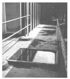
boxen. Das Nakkenrohr trägt zur Sauberhaltung der Boxen bei. Diese Einrichtung verhindert, dass die Kuh mit allen Füssen im Liegebett steht.
