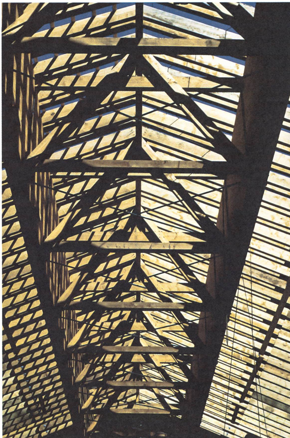
Die beiden mächtigen Brettschichträger, die Querverbindungen und die Windversteifungen vereinigen sich mit der Firstpfette und den Sparren zu einer eindrucklichen Holzkonstruktion.
