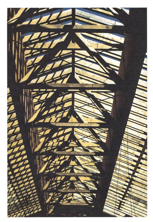
Die beiden mächtigen Brettschichtträger, die Querverbindungen und die Windversteifungen vereinigen sich mit der Firstpfette und den Sparren zu einer eindrücklichen Holzkonstruktion.
