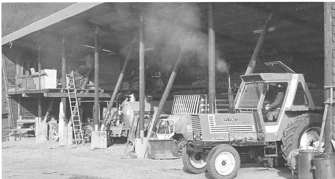
Die Rundholzkonstruktion ist zweckmässig, kostengünstig und gefällt auch aus ästhetischer Sicht.
