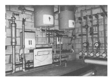
Abb. 5: Entschwefelungsanlage (4) im Heizungsraum.
