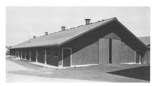
Abb. 1: FAT-Anbindestall mit integrierter Biogasanlage (Unterflur).
