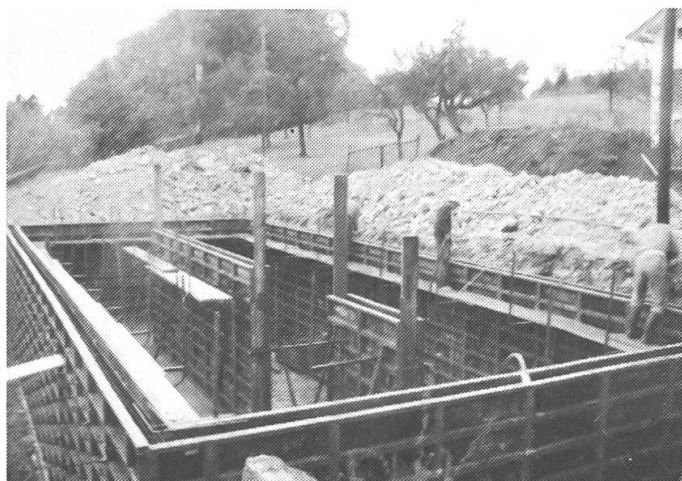
Wandschalung beim Neubau einer Rechteckgrube (Betr. J. Berger, Gempfen/SO).
