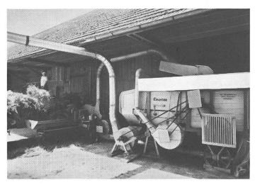
7: Häckseldreschmaschine. Die Garben wurden vom Fuder in den Gebläsehäcksler geworfen. Das Kornhäckselgemisch wurde in die Kleindreschmaschine (Separator) befördert. Nach der Trennung von Korn und Häcksel wurden die Strohhäcksel und die Körner gesondert pneumatisch an die jeweiligen Lagerplätze gefördert.
