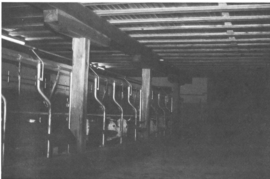
Durch Hinterlüftung der Decke ist auch bei bestehenden Stallbauten eine wirkungsvolle Sanierung möglich.
