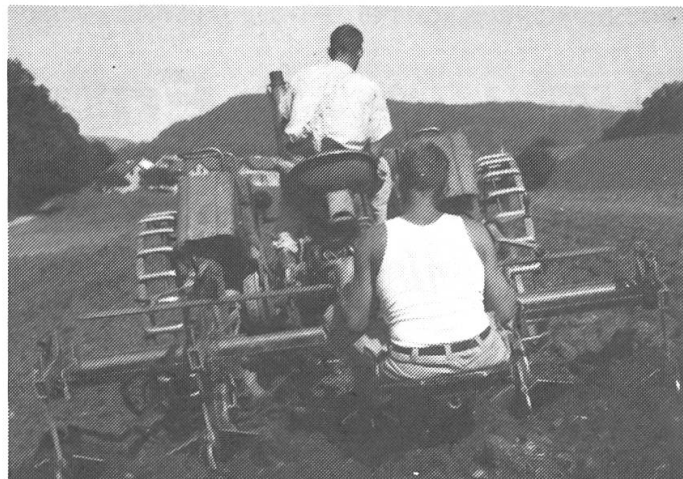
3: Die anfängliche Frage, Vier- oder Dreipunkthanhangung wurde vor allem durch die Arbeiten in geneigtem Gelände entschieden. Nur beim Dreipunktbau war dank der Seitenbeweglichkeit der reibungslose Einsatz von Vielfachgeräten möglich.
