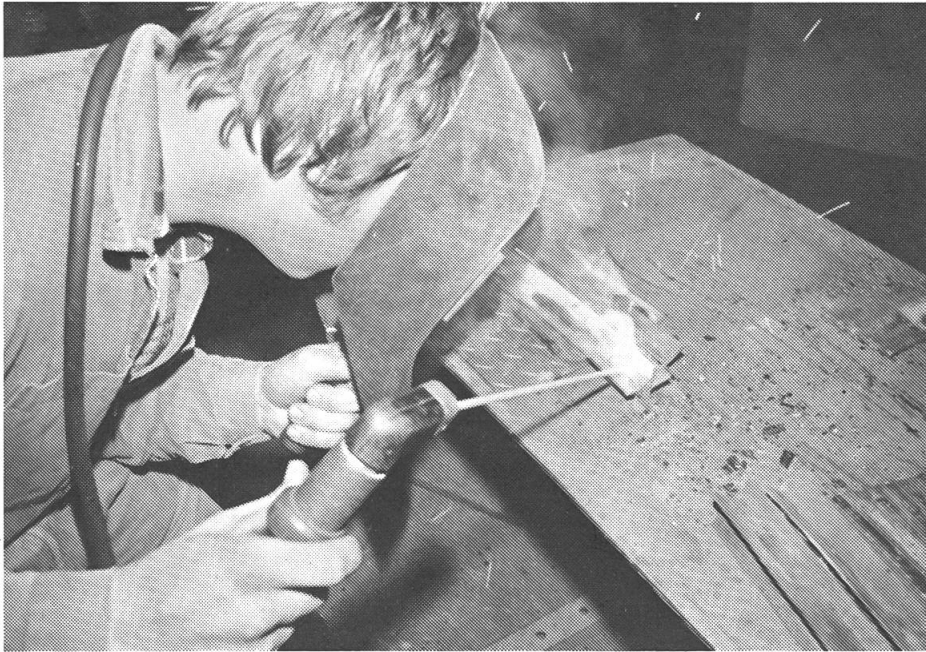
Elektrodenschweissung.
