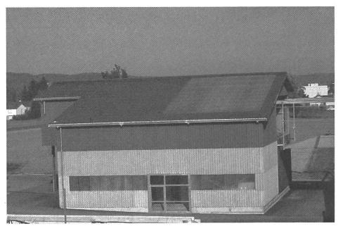
Abb. 1: Halle für Lagerungstechnik mit zwei Sonnenkollektoren, links Blechdach und rechts Kunststoffdach als Kollektor ausgebildet.
