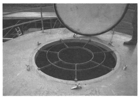
Bei neuen Silos wird eine Abstiegsicherung nach innen verlangt. Ein Rost oder eine Umwehrung hätten genügt, um in einem Jahr zwei tödliche Silounfälle zu verhindern.
