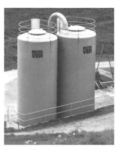
Sichere Siloanlage mit Geländer und gesicherten Aufgängen. Solange die Gebläseanlage montiert ist, kann ein Silo leicht belüftet werden.
