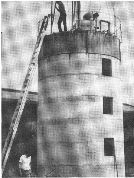
Abb. 2: Beim Betonieren des siebten Meters des FAT-Betonsilos. Drei Arbeitskräfte, wovon zwei auf dem Silo (schwindelfrei).
