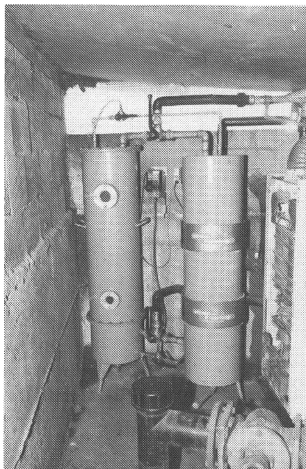
Abb. 4: Entschwefelungsanlage mit zwei Kolonnen für die Reinigung von 50 m 3 Biogas pro Tag.
