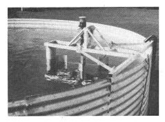
Behälter mit 313 m³ Inhalt anlässlich der Dichtigkeitsprobe mit Wasser.
