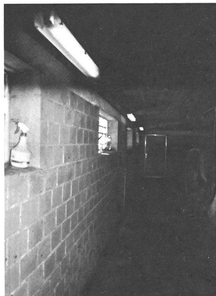
5: Stallbeleuchtung mit zu grossem Abstand der Leuchtstoffröhrenlampen. Man sieht deutlich den Lichtabfall zwischen den Lampen. Dort ist die Beleuchtungsstärke ungenügend für hygienisches Melken.
