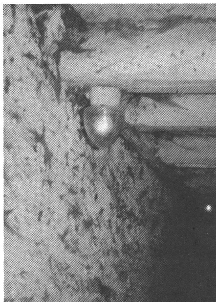
3: Zwei 60-Watt-Glühlampen im Abstand von 6–10 m geben ein absolut ungenügendes Licht für einen Kuhstall. Beizufügen ist, dass die Verschmutzung von Lampe, Wänden und Decken die Wirkung der Beleuchtung beträchtlich vermindert.
