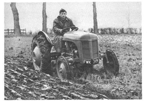
Abb. 5: Das berühmte TE-20-Modell Massey-Ferguson, ursprünglich 23,9 PS, später 28,5 PS, nach 1951 34 PS.
