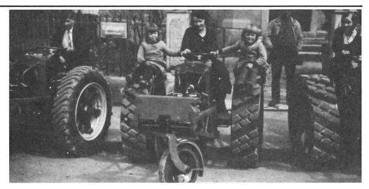
Abb. 6: S.L.M.-Traktor, Baujahr 1932, beim Gülleausbringen. Man beachte, dass das dritte Rad (Stützrad vorn) enfernt wurde, so lastet sämtliches Gewicht auf den Triebrädern.
