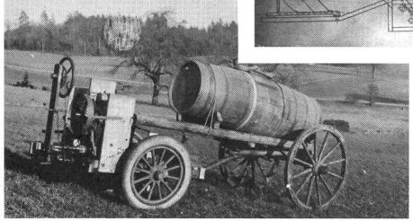
Abb. 2: Erster Prototyp des Waser'schen Einradtraktors (1924). Das gut sichtbare linke Pneurad dient lediglich als Montagestütze. Das Hauptantriebsrad befindet sich verdeckt durch den Kasten – dahinter.
