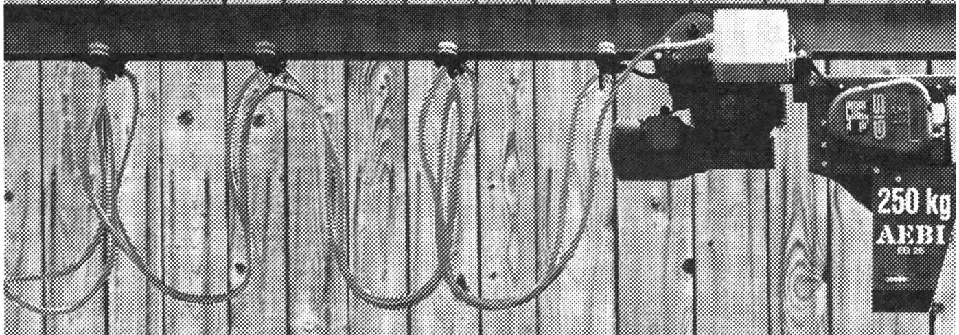
Er reisst 250 kg, entnimmt pro Greifer bis 130 kg Heu, fährt 40 m/min. und hebt und senkt 16 m/min. Er erreicht die hinterste Heustockecke, überwindet Steigungen bis 15° und besitzt ein selbsthemmendes Fahrgetriebe. Vom Heustock aus werden alle Funktionen fernbedient, die Gabel entlädt entweder am Boden oder zu oberst im Anschlag.
