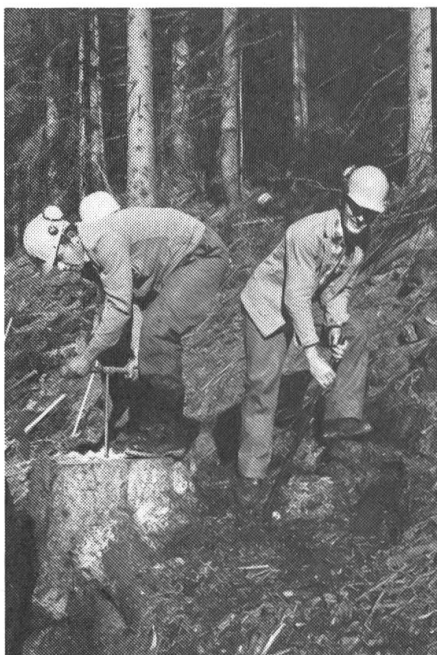
Die Ausbildung in den Sprengkursen des SVW/SBV ist praxisnah und vermittelt die nötigen Kenntnisse zur Erlangung der Ausweise A oder B.
