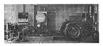
Abb. 4b: Der zweite Bremsstand des IMA (Wasserwirbelbremse), wurde offziell am 16. September 1958 in Betrieb genommen.
