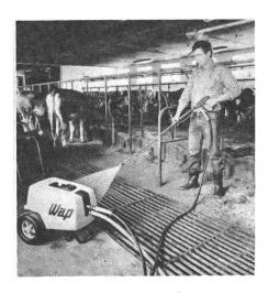
Für die universelle Reinigung ist der neue Landwirtschafts-Hochdruck-reiniger WAP L 3000 mit Warmwasserstufe und Reinigungsmittelansaugung geeignet. Mit einer völlig neuen Hochleistungsradialpumpe mit Vollkeramikkolben, wird bei reduzierter Wassermenge das Waschwasser im Kreislaufbetrieb ohne zusätzliche «Heizkosten» auf 30° C erwärmt. Das erhöht den Reinigungs- bzw. Desinfektionseffekt und ist ideal für die Tierwäsche.
