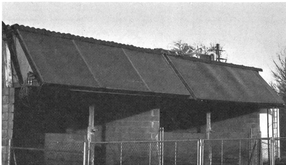
Abb. 1: Sonnenkollektor für die Warmwasseraufbereitung im praktischen Vergleichstest an der Forschungsanstalt Tänikon (FAT).
