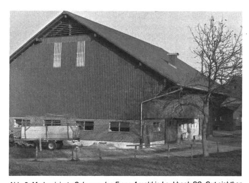
Abb. 2: Modernisierte Scheune des Franz Arnold in Laubbach SG. Gut sichtbar ist die Lufteintrittsöffnung im Firstdreieck für die Heubelüftung mit Sonnenkollektor.
