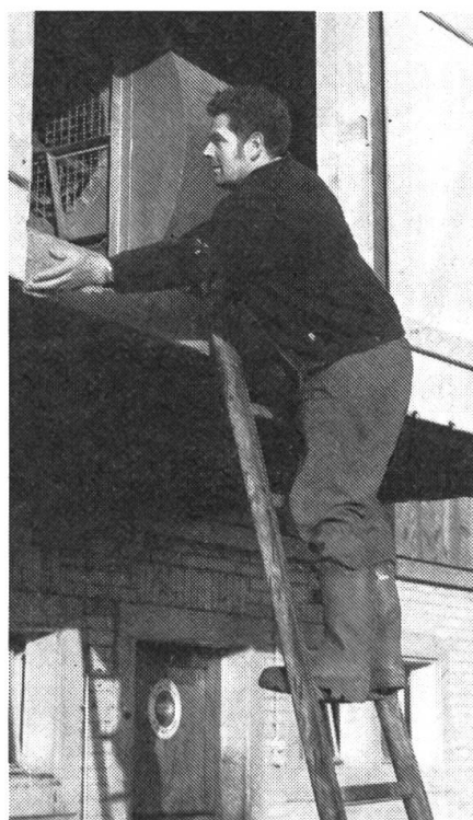
Abb. 4: Über eine kurze Leiter ist der Zutritt zu den Ventilatoren möglich. Landwirt Franz Arnold (Bild unten) hat auch die Möglichkeit vorgesehen, die Ventilatoren mit kalter Frischluft zu beschicken.
