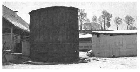
Abb. 2: Bildmitte: Der isolierte Biogasreaktor. Rechts: Lagersilo für vergorene Jauche, zugleich Speicherraum für das produzierte Biogas.
