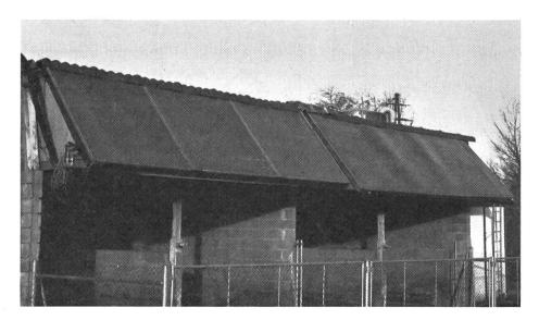
Abb. 1: Sonnenkollektor für die Warmwasseraufbereitung im praktischen Vergleichstest an der Forschungsanstalt Tänikon (FAT). Die Kollektoren auf dem Offenfrontstall sind nach Süden gerichtet, mit einem Winkel von 45° angestellt.
