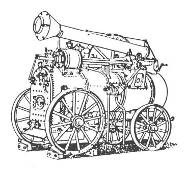
Abb. 1: Dampflokomobil von Hofherr-Schrantz (1890).
