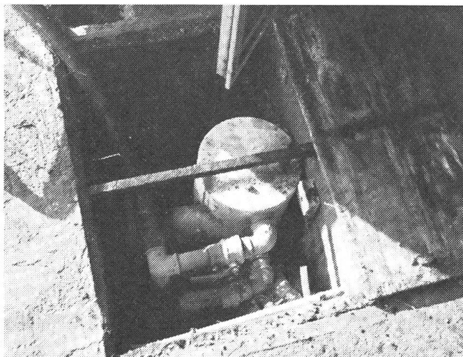
Abb. 2: Kondenswasser-Abscheider mit Zu- und Ableitung.
