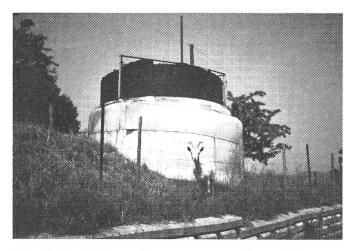
Abb. 3: Der isolierte Nassgasometer dient als Vorratsbehälter, um allfällige Produktionsschwankungen überbrücken zu können.
