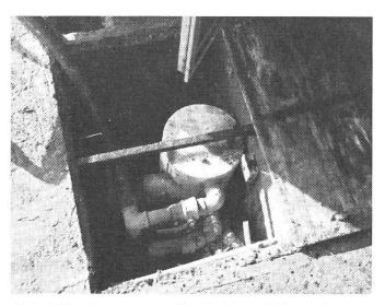
Abb. 2: Kondenswasser-Abscheider mit Zu- und Ableitung.
