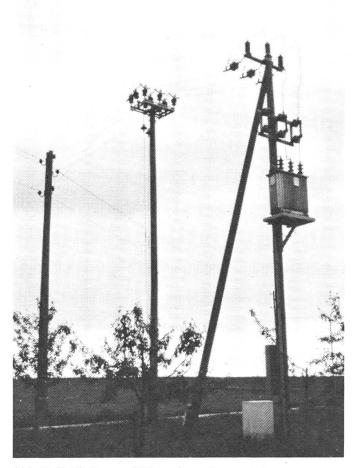
Abb. 1: Freileitung mit Transformatorenstation in der Nähe eines abgelegenen Gehöftes.
