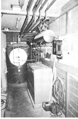
Abb. 2: Wärmepumpe mit dahinterstehendem Pufferspeicher (Foto LBA)
