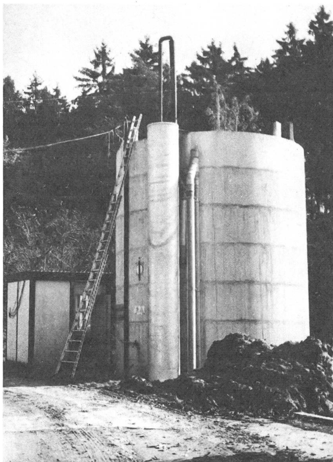
Abb. 2: Biogasanlage mit Güllewärmetauscher und Messkabine.
