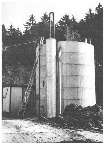
Abb. 2: Biogasanlage mit Güllewärmetauscher und Messkabine.
