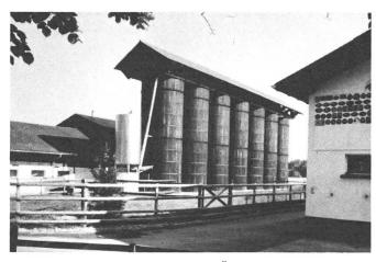
Hegner-Siloanlage mit Spezial-Überdachung und vollmechanisierter Entnahme für Mischfütterung auf einem der grössten Schweizer Schweinemastbetriebe.
