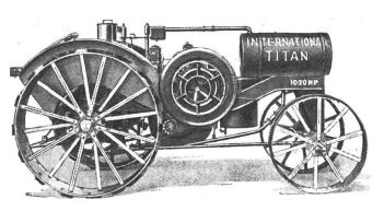
*Traktor Titan (1917),* importiert durch die International Harvester Company, Zürich. 2-Zyl.-Petrolmotor mit Kettenantrieb.
