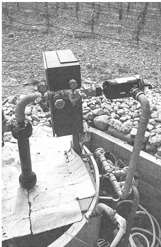
Abb. 5: Filterbatterie und Düsenprogrammierer zu Tropfenberegnieranlage in Prangins VD.
