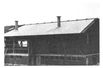
Abb. 2: Ins Dach integrierter Sonnenkollektor. Die kostengünstigste Art, einen Kollektor zu bauen. Der Mehrpreis beträgt im Mittel aller solcher Anlagen Fr. 31.–/m².
