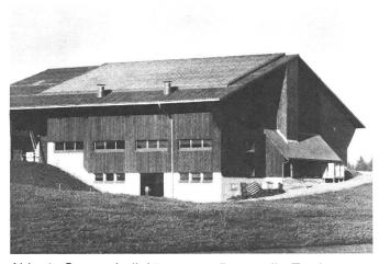
Abb. 1: Sonnenkollektoren erwärmen die Trocknungsluft der Heubelüftung. Hier eine Anlage mit 250 m² Kunststoffplatten auf ein bestehendes Dach montiert. Aus Gründen des Landschaftsschutzes und der Feuerpolizei gewinnen aber heute sogenannte schwarze Dächer immer mehr an Bedeutung.
