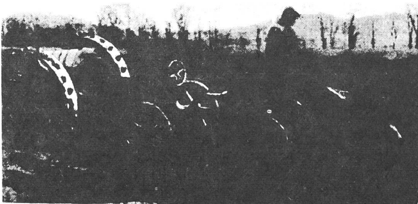
Traktor Greif (1918) der Zentralheizungsfabrik, Ostermundigen. Sog. Vorderzugtraktor, 4 Zyl., 12/18 PS.
