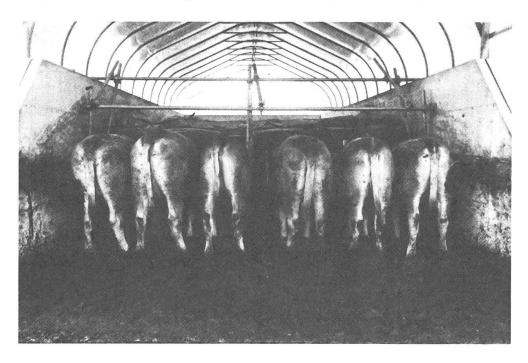
Abb. 5: Spannvorrichtung am Fressgitter bei Selbstfütterung. Im Hintergrund eine Gruppe fressender Tiere.
