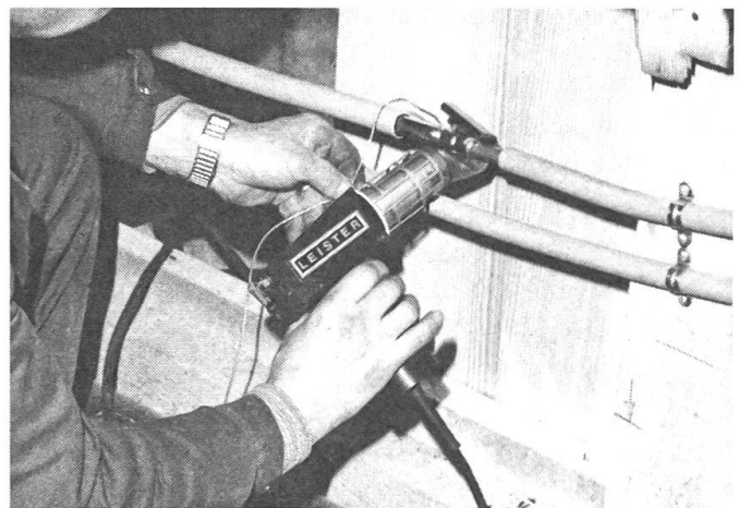
Abb. 3: Löten einer Kupferrohr-Warmwasserleitung ohne Brandgefahr für Holz, Kabel und Kunststoffleitungen. Lötdauer: 20 Sekunden.
