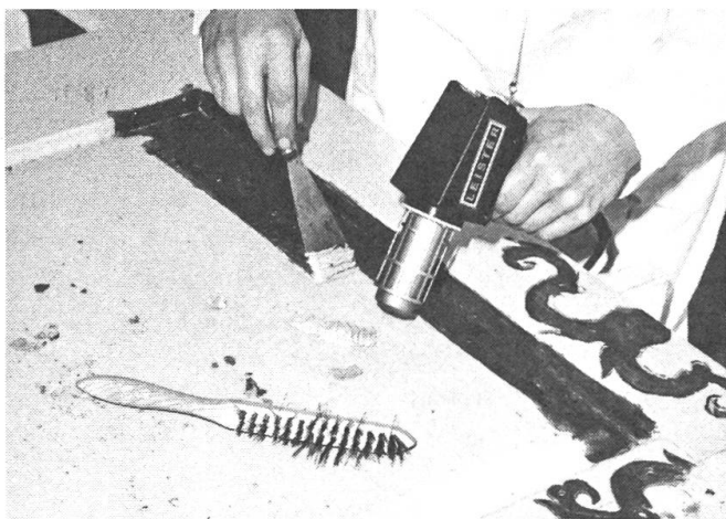
Abb. 1: Staubfreies Entfernen alter Öl-, Schellack- und Kunstharzfarben mit dem kräftigen Heissluftstrahl des Leister-Ghibli. Kein Verbrennen des Untergrundes. Minimale Nacharbeit. Wenig Geruchsentwicklung. Hilfreich bei Trockenproblemen und Ablösen von Tapeten.
