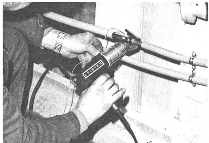
Abb. 3: Löten einer Kupferrohr-Warmwasserleitung ohne Brandgefahr für Holz, Kabel und Kunststoffleitungen. Lötdauer: 20 Sekunden.
