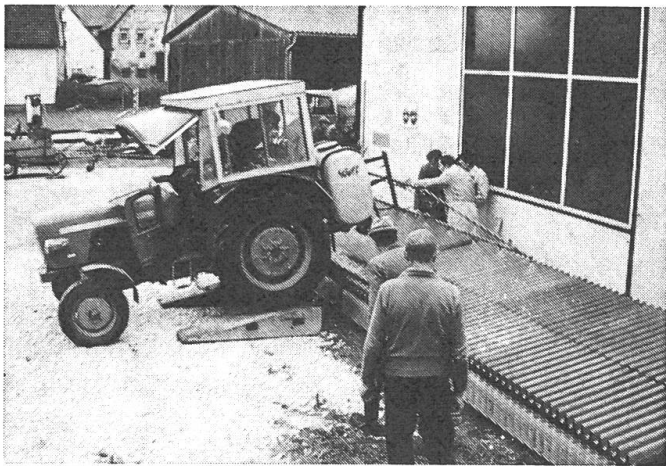
Abb. 2: Auf dem «Dositest» (Rinnenbrett) wird die Querverteilung der Düsen kontrolliert.
