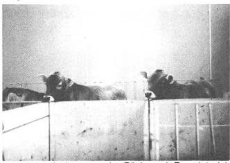
Abb. 11: Aufnahme von der Rückwand. Es zeigt sich hier, dass eine Wandhöhe von 110 cm ab Rost bei vier Monate alten Kälbern nicht genügt. Es besteht die Gefahr, dass die Kälber aus der Boxe springen oder es zumindest versuchen. Die Wandhöhe sollte darum auf 130 bis 140 cm erhöht werden.
