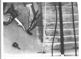
Reparaturschweissung an einem Polyäthylentank. Viele Tanks, Rohre, Körbe und Eimer bestehen aus dem gut schweissbaren Polyäthylen.
