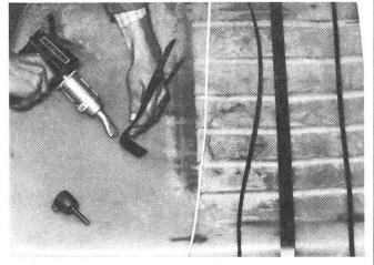
Reparaturschweissung an einem Polyäthylentank. Viele Tanks, Rohre, Körbe und Eimer bestehen aus dem gut schweissbaren Polyäthylen.
