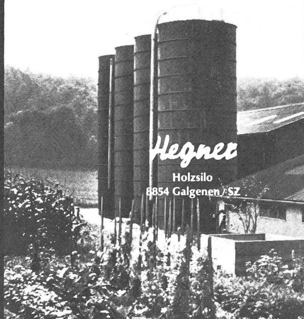
Hegner-Holzsilos sind massiv aus Föhrenholz hergestellt. Die spezielle Druckimprägnierung ist säurebeständig und garantiert jahrzehntelang keinen Unterhalt.
