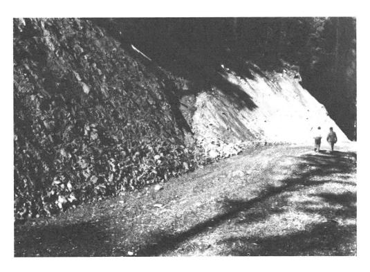
Die Hydrosaatmethode kann gerade im Bereich der Böschungsstabilisierung oft erfolgreich angewendet werden. Unser Bild zeigt eine Fläche vor und nach der Behandlung mit Hydrosaat.
