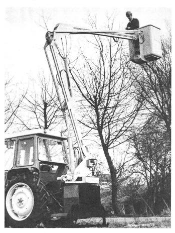
Diese neue Vorrichtung kann bis zu Höhen von 9,6 m gehoben und, wie berichtet wird, an jedem normalen Traktor angebaut werden. Das B 10-Gerät erweitert den Einsatz normaler Traktoren in der Forstwirtschaft, im Obstbau, in der Bauindustrie und für den Gebäudeunterhalt sowie auf zahlreichen anderen Sektoren.
