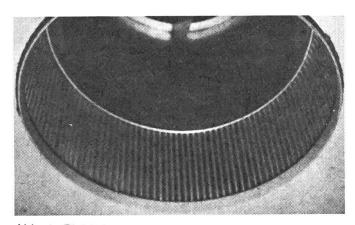
Abb. 4: Einblick in den Faltenbalg-Wärmetauscher (abluftseitig).
