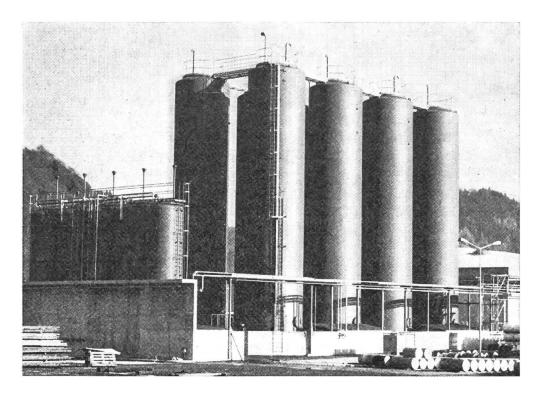
Abb. 3: Uebersicht über die neue, den Gewässerschutzvorschriften entsprechende Tankanlage. Kapazität z. Z. 2,2 Mio Liter.
