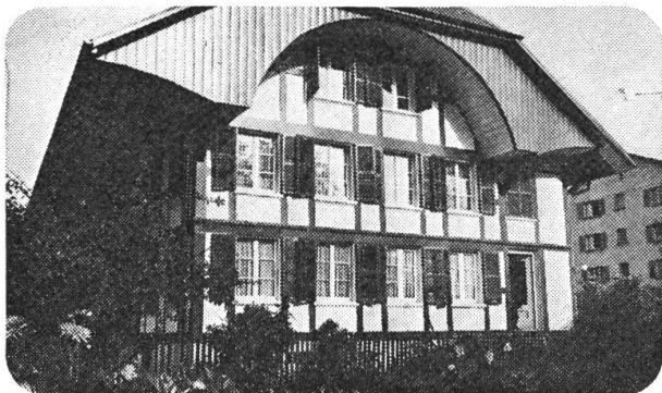
**Bildlegende:** HEGLAS-Isolierglas mit Sprossen, damit das charakteristische Aussehen erhaltenswert Fassaden bestehen bleibt.
