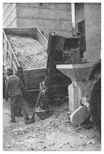
Abb. 4: Korn-Spindelgemisch wird hier stationär geschrotet.
