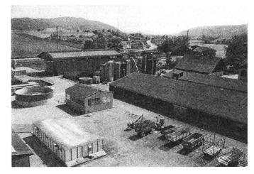
Die technischen Anlagen aus der Vogelschau. Die Leichtbauweise verschiedener Hallen ermöglichte beträchtliche Kosteneinsparungen. Gleichzeitig lassen sich diese Hallen leicht umbauen. (Foto: W. Bühler)
